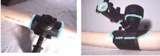
Şekil 13 Semer-mesnet Kaynağının Köpük ile Kontrolü
