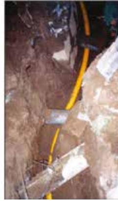
Şekil 6 Polietilen Altyapı Geçışı
